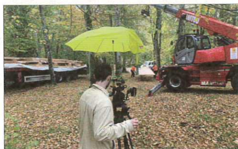
Mise en place des panneaux Hexapli
