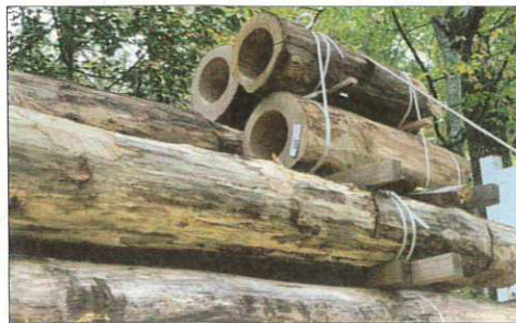
Éléments pour l'emboîtement des "poteaux"
