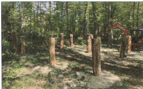
Mise en place des piliers (à plus d'1 m sous terre).
