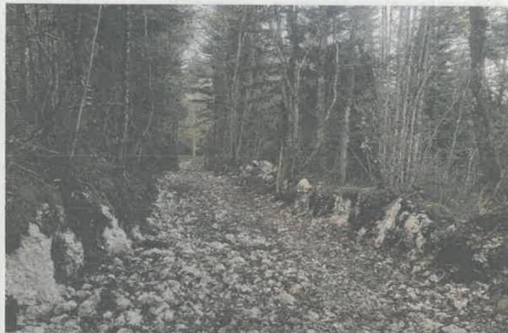
Un brise-roche a été utilisé sur une dizaine de mètres pour élargir un chemin qui doit permettre aux véhicules de passer.
